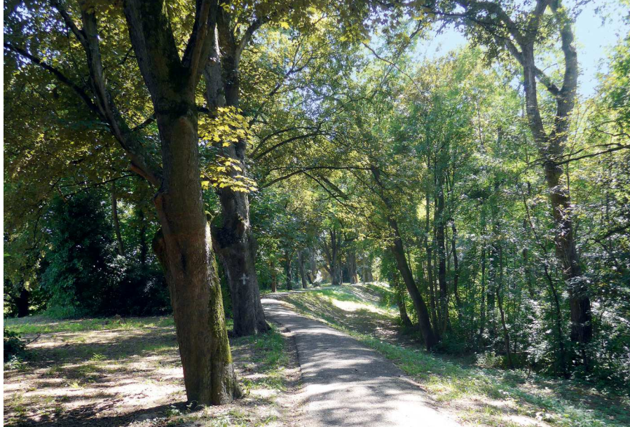
Abb. 3: Baumbestander Rheindamm Mannheim, mit bis zu über 11 Meter wesentlich breiter als ein Normdamm mit 3 Meter beziehungsweise 5 Meter breiter Krone. Weit mehr als 1000 Bäume wachsen hier. Die Ausnahmeregel in den Regelwerken DIN für Bäume setzt überbreite Dämme voraus, war hier gegeben ist
